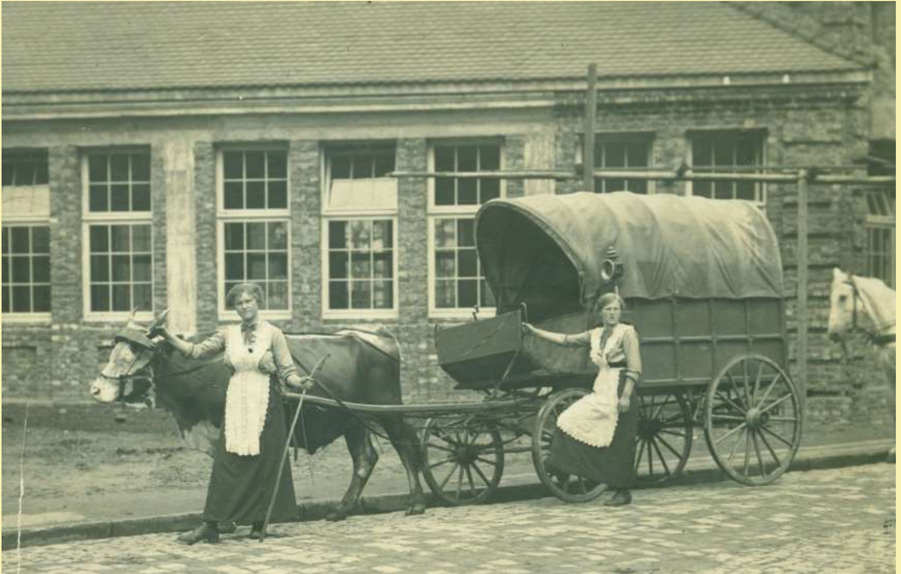
1916 Marktbeschicker vor dem Rohbau der Markthalle
