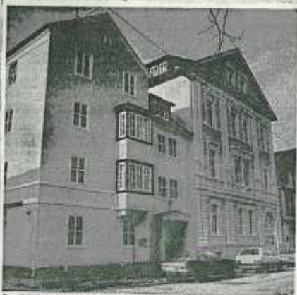
Das DOHM-Hotel an der Löhstraße 4 und 6 öffnet heute nach über einjähriger Umbauzeit seine Pforten. Es verfügt über 70 Betten und ist auf das Modernste eingerichtet. Das ehemalige Altersheim und die alte Zigarettenfabrik wurden zu einem denkmalgeschützten Ensemble gestaltet. Foto: NW (Borowka)
