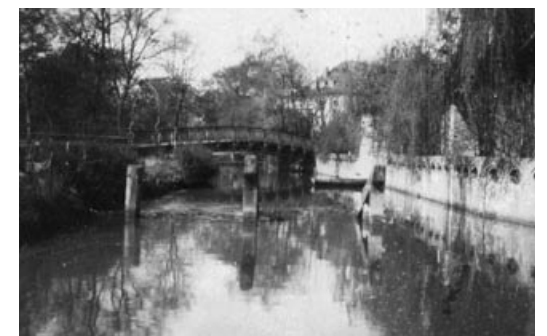
Gleichzeitig begannen Planungen für einen Umbau des Wehres an der Mühle selbst. Bilder zeigen den alten Zustand mit hölzernen Eisbrechern, die bei den damals noch häufigen Winterisgängen gute Dienste leisteten.
