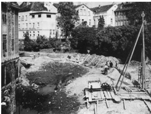
1933 schufen umfangreiche größere Bau-massnahmen eine betonierte Kanalisierung...
