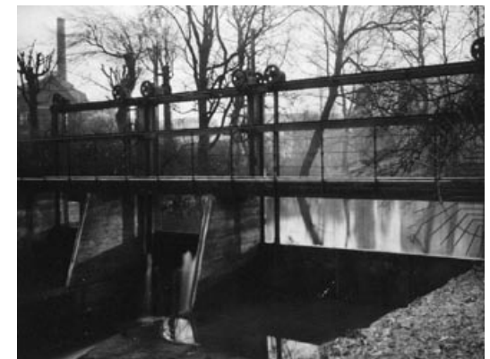
1930 wurde an der Umflut zum Stadtgraben eine neue Stauanlage in Betrieb genommen, die bis heute genutzt wird.
