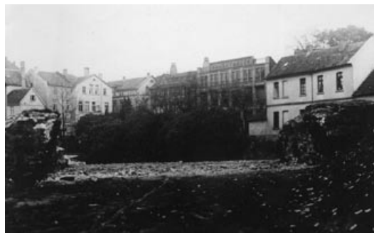
Im Zuge der Baumaßnahmen verschwanden auch die letzten Reste der steinernen Ret-berg-Befestigungsbögen.
