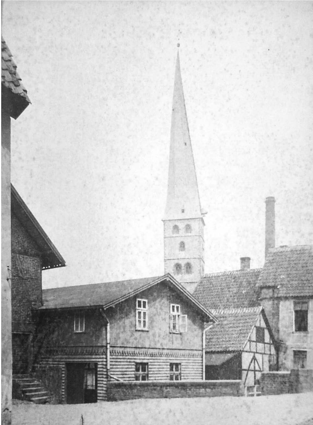
Foto von Süden aus dem Gutachten von 1878.
