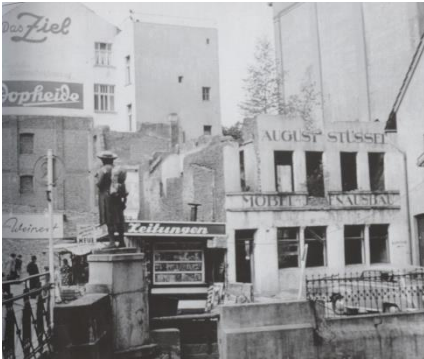
Die zerstörte Fabrik 1945. (Foto: Geschichtsverein)
