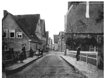
Foto von 1890. Blick in die Radewiger Straße. Direkt hinter dem traufenständigen Gebäude auf der linken Seite, erhebt sich
