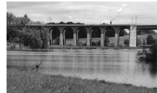
Blick auf den Obersee mit Viadukt (Foto: F. Becker)
