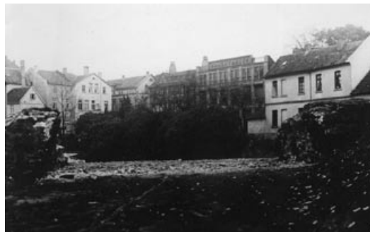
Im Zuge der Baumaßnahmen verschwanden auch die letzten Reste der steinernen Ret-berg-Befestigungsbögen.
