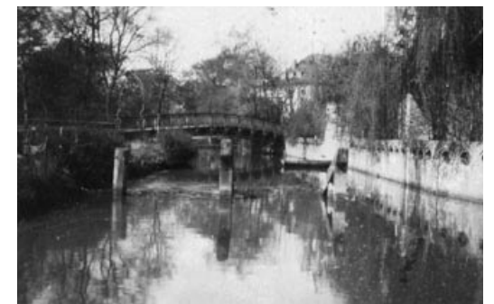
Gleichzeitig begannen Planungen für einen Umbau des Wehres an der Mühle selbst. Bilder zeigen den alten Zustand mit hölzernen Eisbrechern, die bei den damals noch häufigen Winterisgängen gute Dienste leisteten.
