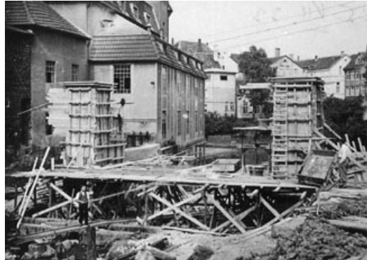
Das Wehr selbst wurde massiv aus Beton und Stahl errichtet.
