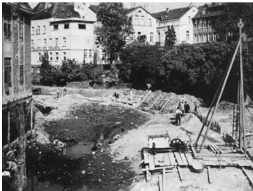
1933 schufen umfangreiche größere Bau-massnahmen eine betonierte Kanalisierung...
