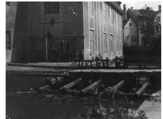
Auch das Wehr selbst bestand zum größten Teil aus Holzbauten.
