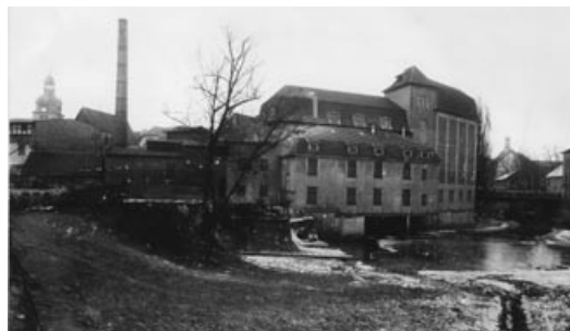
Nach dem Brand von 1912 wurde auch die Wehranlage erneuert. Ein Foto von 1914 zeigt den Zustand nach dem Wiederaufbau 1912. Erkennbar sind der noch unbefestigte weite Auslauf für die Aa und die zur Befestigung der Stauanlage des Wehres benutzten massiven Grabplatten.
