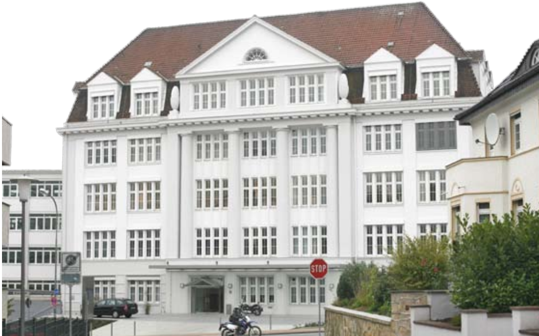
Die sanierte Fassade des Leineweber-Verwaltungsgebäudes.
