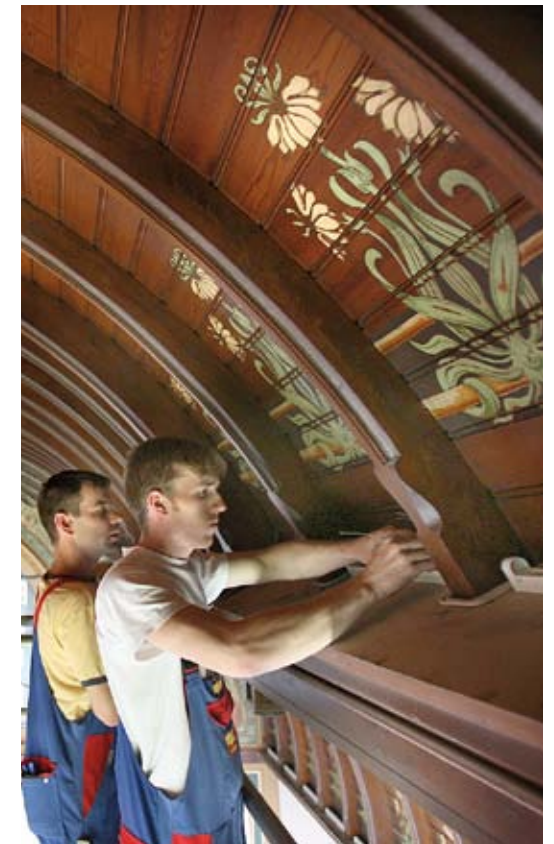
Das restaurierte Tonnengewölbe (S. 4). Detailfotos zu den Restaurierungsmaßnahmen.
