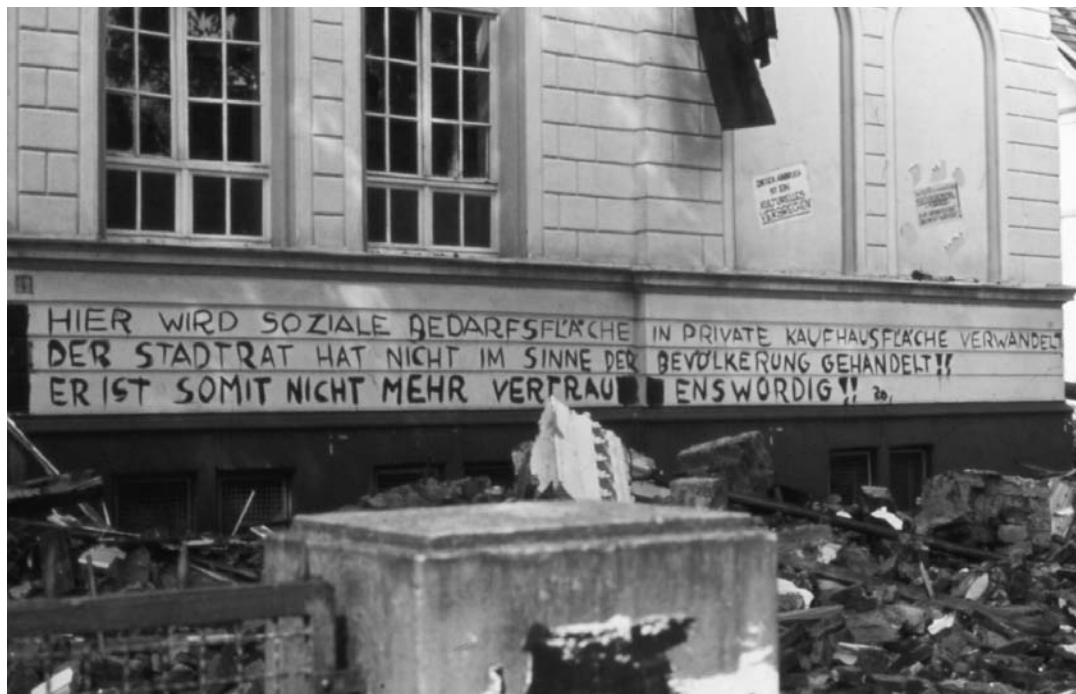
Abriss des FGH 1972.
