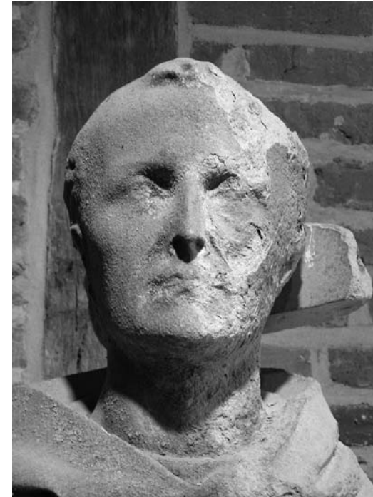
Das Baumberger-Sandstein-Museum dokumentiert Schäden durch den sauren Regen.
