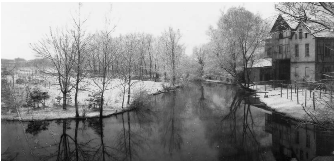
Die Aa an den Abflüssen Eisgraben (nach links) und Stadtgraben (nach rechts) vor der Begradigung.
