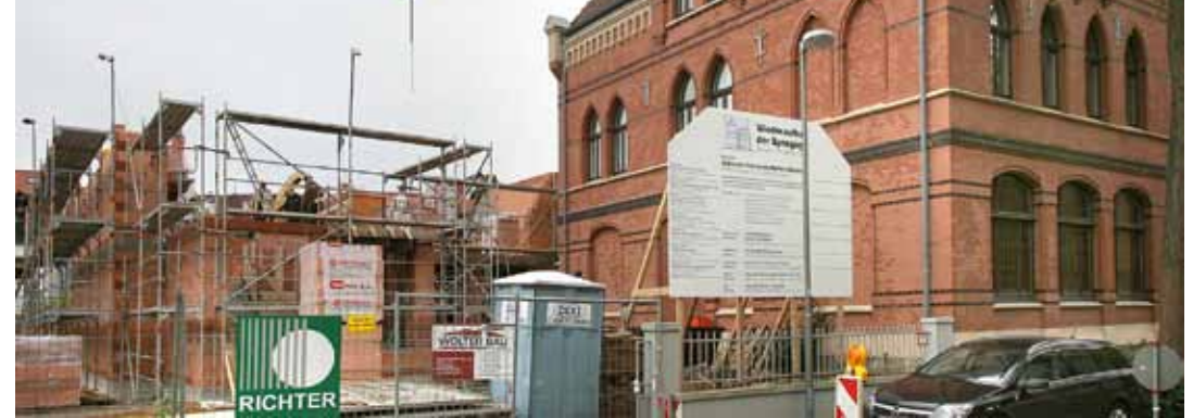
Präsentation des Modells anlässlich des ersten Spatenstichs, der Rohbau der Synagoge 2009
