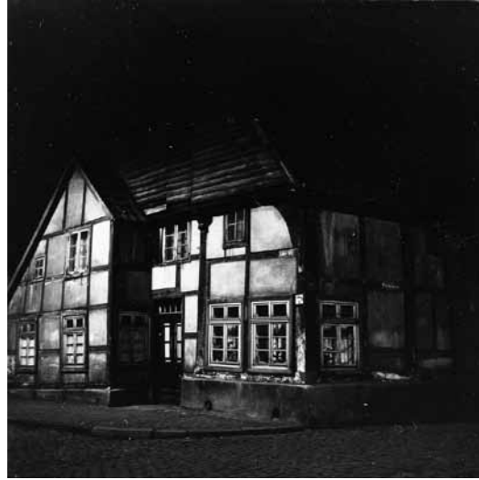
Das alte Kantorhaus an der Ecke Löhrstraße/ Kirchgasse wurde, unmittelbar nachdem diese tolle Aufnahme gelang, abgebrochen. Lück war dafür extra im Dunkeln mit Stativ in die Radewig gegangen.
