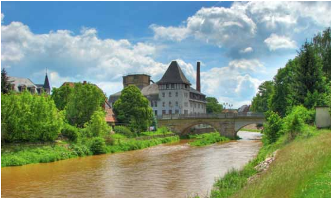
Die 1946 restaurierte Brücke in Nossen
