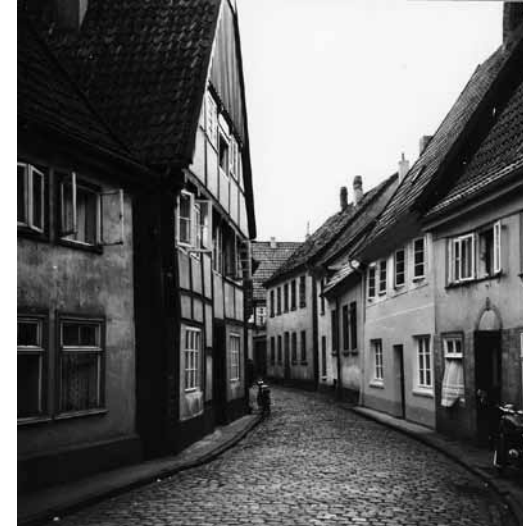
Von der Fidenstraße existiert nur noch der Name. Alle Gebäude wurden hier abgerissen. Heute befindet sich an dieser Stelle die Einfahrt zum Parkhaus Neustadt.
