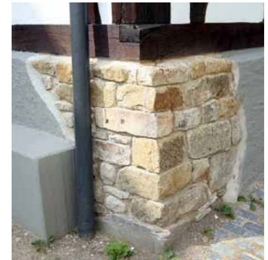
unten: Freigelegte Mauerecke an der Rückseite
