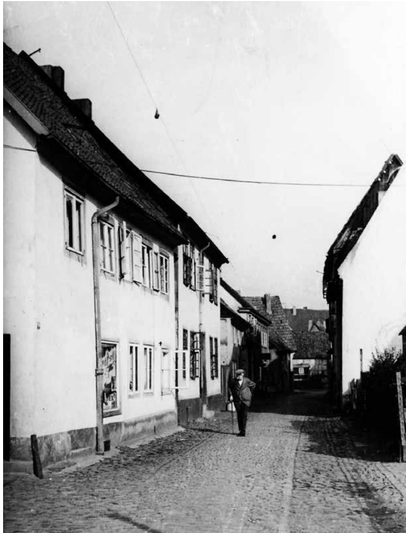
Abb. 4: Bergertormauer um 1943; Blick von der Einmündung Fidenenstrasse in Richtung Einmündung Rosenstrasse – links die Einmündung der Fidenenstrasse – es folgen die Häuser Bergertormauer Nr. 20 (Händler Heinrich Becker), Nr. 22 (Erben Schröder), Nr. 24 (Malermeister Johann Schlimgen), Nr. 26 (Witwe Anna Feller), Nr. 28 (Klempnermeister Wilhelm Schröder), Nr. 30 (Rentner Louis Borges) Nr. 32 (Maurer Albert Hertel), – dahinter die Einmündung mit der Rosenstrasse – rechts die Häuser Nr.31 (Schausteller Christian Weber) und Nr.33 (Händler Hermann Helweg)
