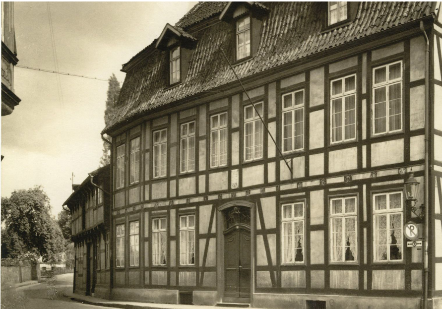
Bergertorstraße Wohnhaus des Sanitätsrats Dr. Nolting // Hist. Fotos: Archiv Geschichtsverein
