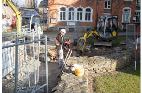
Schweres Gerät im Einsatz bei den Sondierungsarbeiten im Februar 2021 – eine massive Betondecke bedeckt das Bodendenkmal
