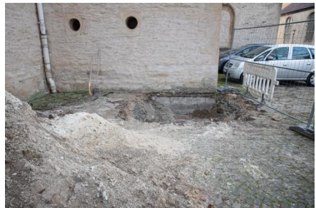
Foto 3: Sondierungsgrabung an der Nordseite der Münsterkirche
