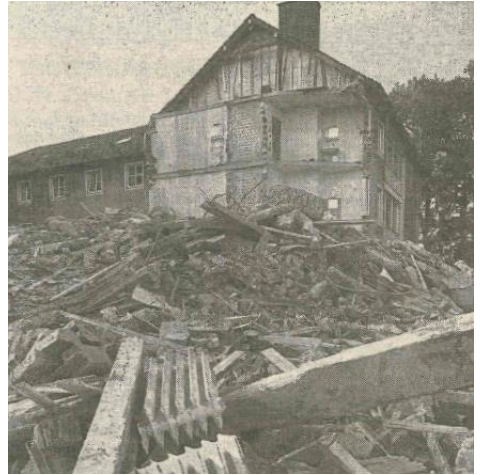
Abriss der „Villa Löwe“ zum Neubau von Maria Rast 1993 (Herforder Kreisblatt)
