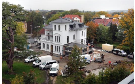
Im Umbau ab 2018
