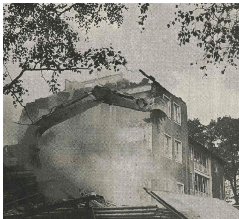
Abriss der „Villa Löwe“ zum Neubau von Maria Rast 1993 (Neue Westfälische)
