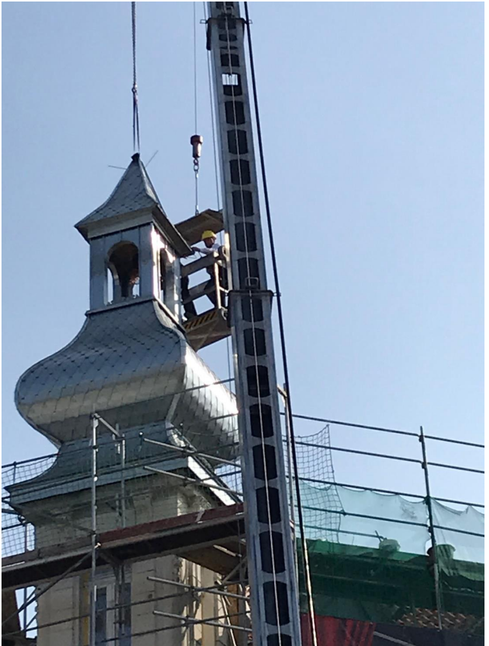
Am 24. September 2020 wird die neue Turmhaube aufgesetzt (C. Laue)
