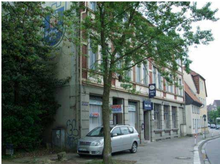
Der Zustand vor der Renovierung (Mathias Polster)
