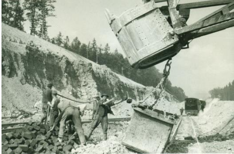
Arbeiten beim Durchbruch des Stuckenbergs 1938 (Foto: Fenske, Kommunalarchiv)
