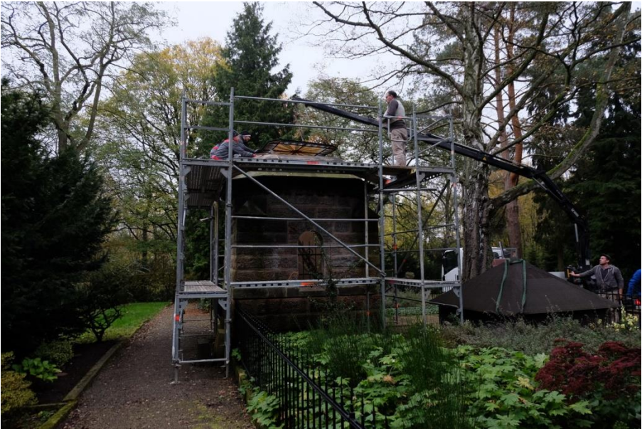
Einbau des Glasdachs 2017 (Foto: Kiel-Steinkamp)
