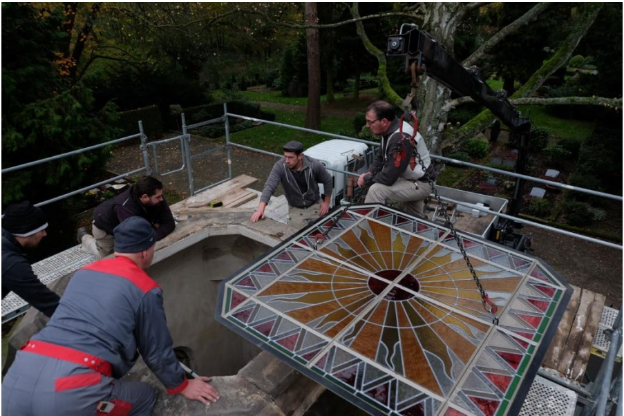
Einbau des Glasdachs 2017 (Foto: Kiel-Steinkamp)
