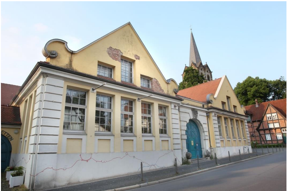
2018 Vor dem Umbau (Foto: Kiel-Steinkamp)
