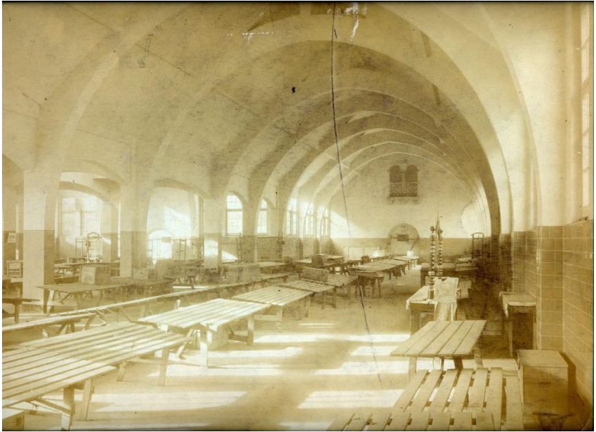
1918 Blick in die fertige Markthalle (Foto: Kommunalarchiv)
