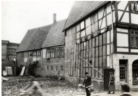
Die Twegte, die Radewiger Straße und die alte Mauerstraße (heute Mühlengasse) verband, durfte beim Neubau des Gebäudes Radewiger Straße 19 (vorher Barkhausen) am Anschluss zum Haus 21 nicht zugebaut werden. Auch hier verlief schon vor Jahrhunderten ein schmaler öffentlicher Gang (Foto der Baulücke, der Weg verläuft links vom Bild, Foto: Georg Heese).
