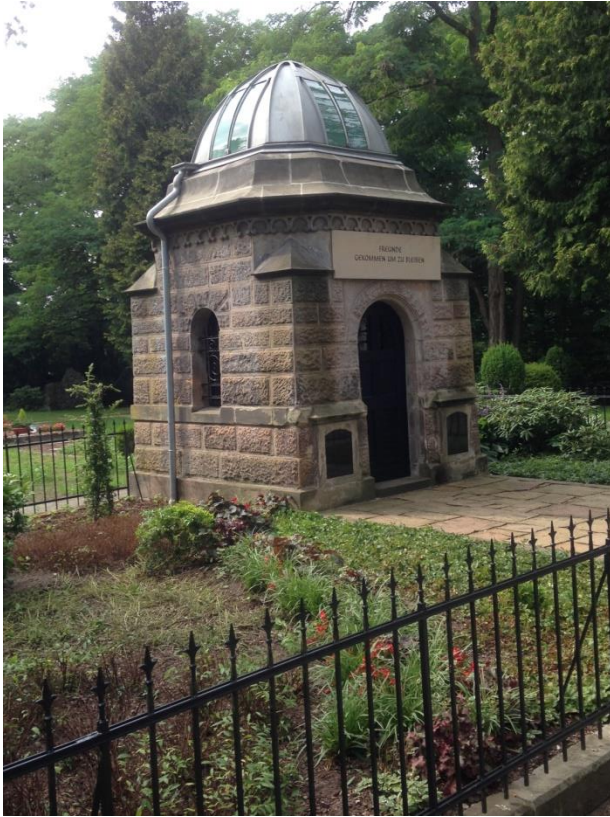
Sanierter Zustand 2019 (Foto: Eckhard Möller)
